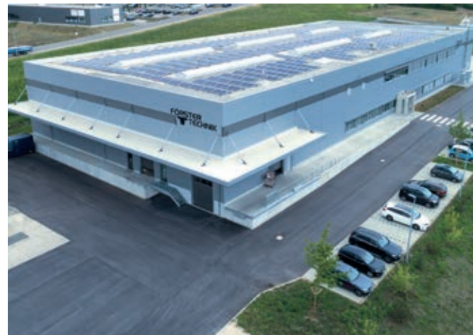
Abb. 5: Die neue Produktionshalle in Engen.
